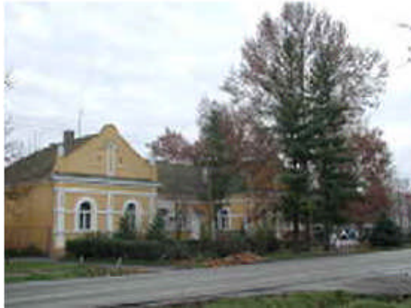
Gemeindehaus in Jarek / Batschka
